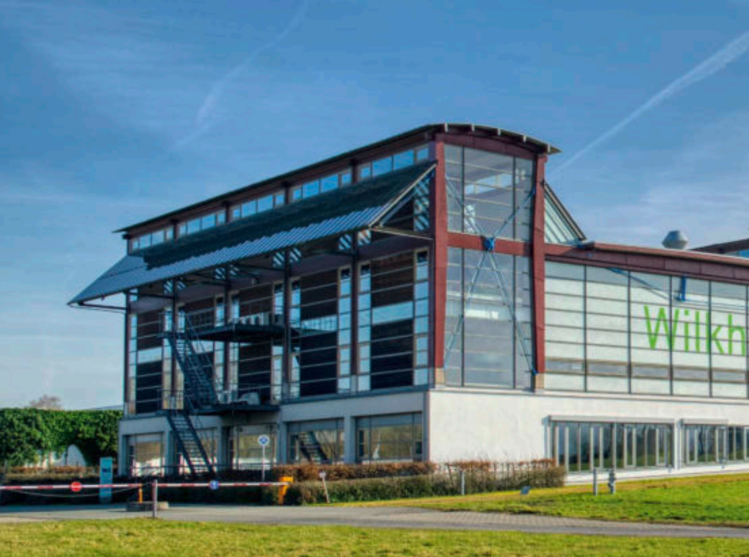
Das Ensemble der Fertigungshallen steht weithin sichtbar für wesentliche Qualitäten langlebiger Produktgestaltung: authentische Materialität, konstruktive Raffinesse und detailgenaue Ästhetik.
